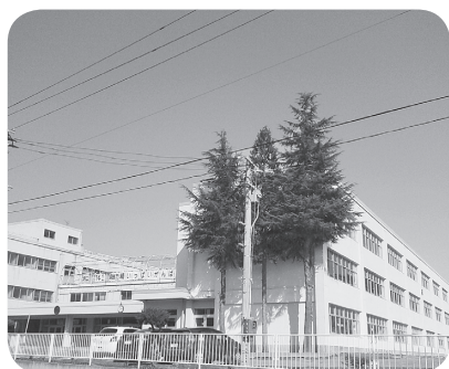
耐震補強をする野辺地小学校
