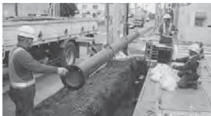
石綿管更新工事現場
