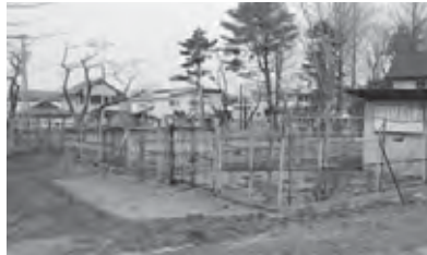
使用していない野辺地小学校プール
