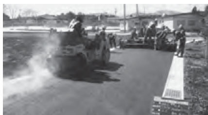
町道御手洗瀬・槻ノ木線舗装新設工事
