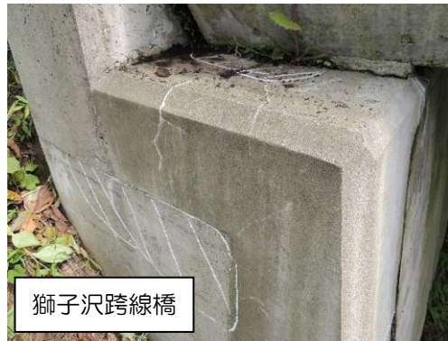
写真 2 橋台の損傷
