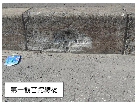
写真 11 縁石の欠損
