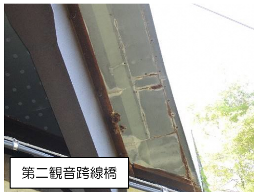
写真 6 床版の損傷
