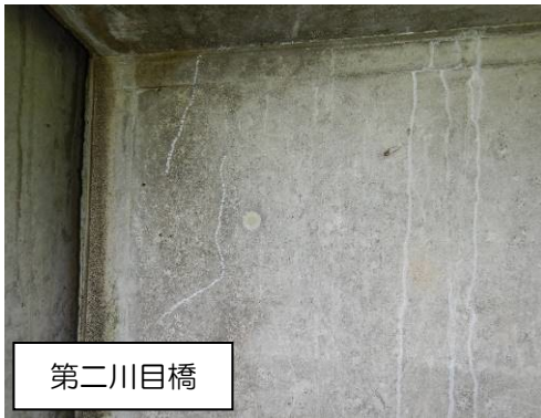
写真 1 主桁の損傷
