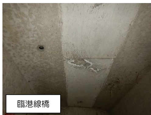
写真 8 床版の損傷
