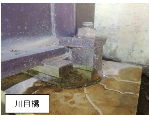
写真 7 支承の損傷
