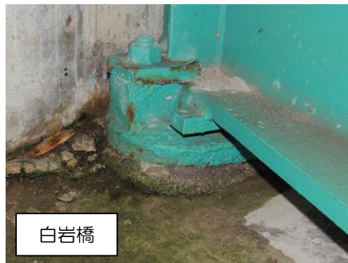
写真 4 沓座モルタルの損傷
