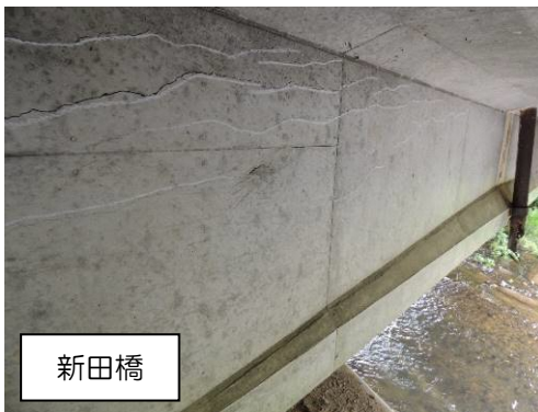
写真 3 主桁の損傷
