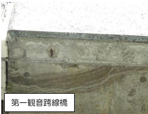
写真 5 床版の損傷
