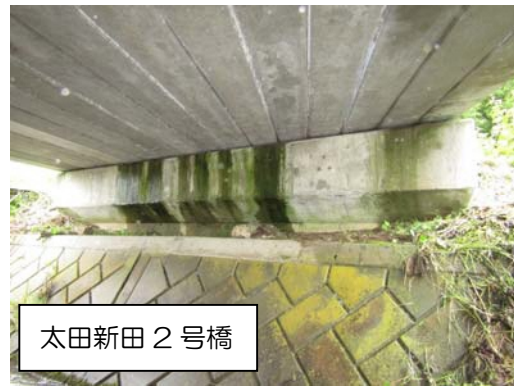
写真 2 橋台の損傷
