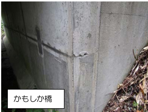
写真 3 橋台の損傷
