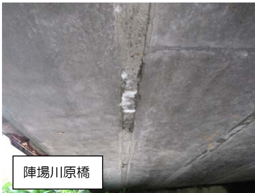
写真 5 床版の損傷
