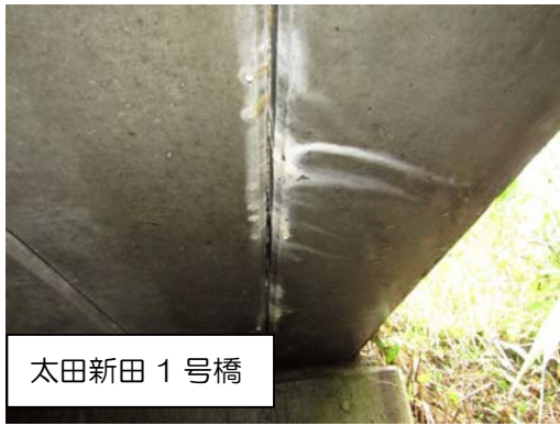
写真 1 床版の損傷
