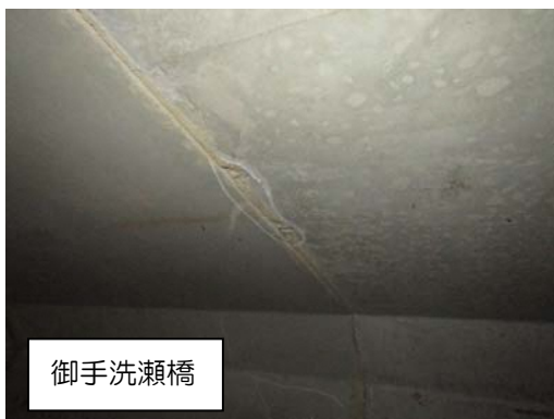
写真 7 床版の損傷
