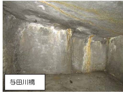
写真 6 橋台の損傷
