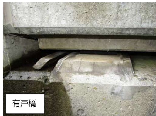
写真 8 沓座モルタルの損傷
