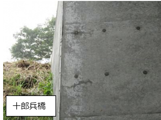
写真 4 橋台の損傷
