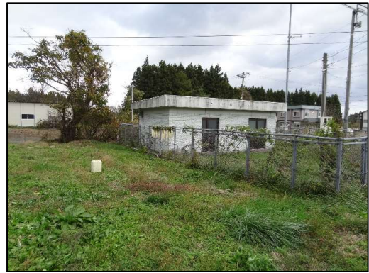
馬門ポンプ場
