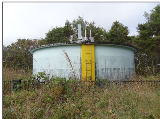
琵琶野配水池
