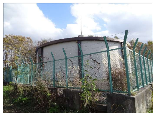
寺ノ沢配水池
