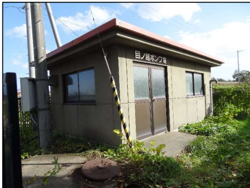
目ノ越ポンプ場
