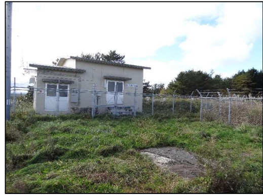
目ノ越配水場 配水池
