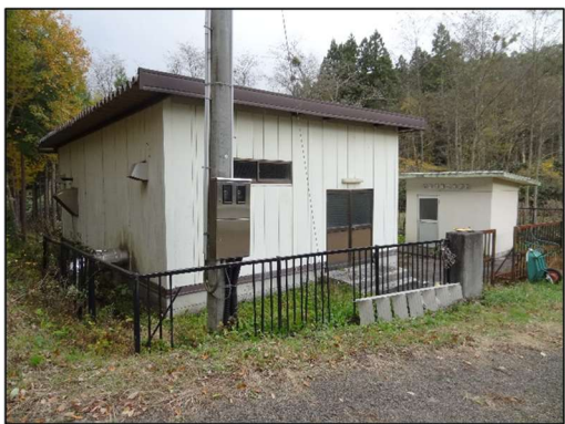
琵琶野取水場 導水ポンプ棟
