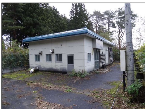
琵琶野ポンプ場 ポンプ室
