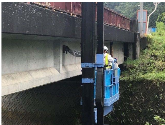
従来の点検方法（橋梁点検車）
