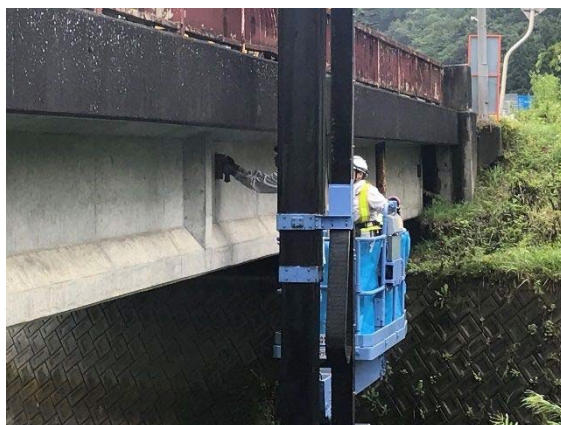
従来の点検方法（橋梁点検車）
