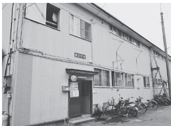
先行して取り壊される第2庁舎
