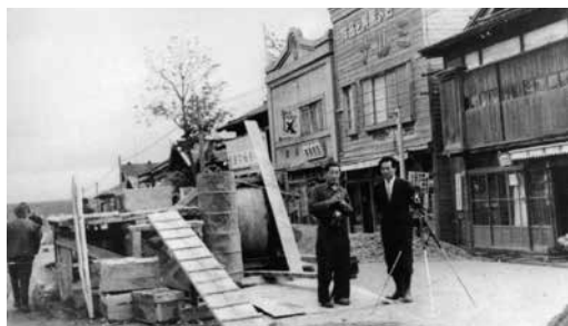
【写真②本町通りの舗装 撮影年代不明】 昭和10年前後の本町通りの舗装をしている写真。写真にロードローラー的なものが写っているような気がしますが、どうやって舗装したのでしょうか。
