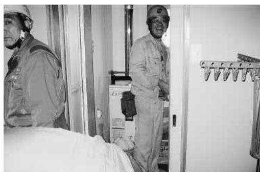
コンセント点検清掃
