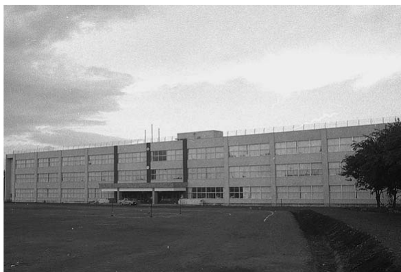
【写真④防音校舎 撮影：1973（昭和48）年】 飛行機の騒音対策のため防音鉄筋3階建の校舎になりました。同年、野辺地小の校舎も新築されます。
