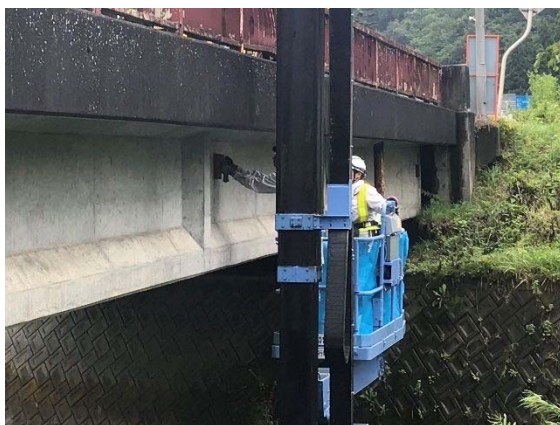
従来の点検方法（橋梁点検車）
