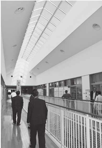
採光のため設置された吹き抜け廊下
