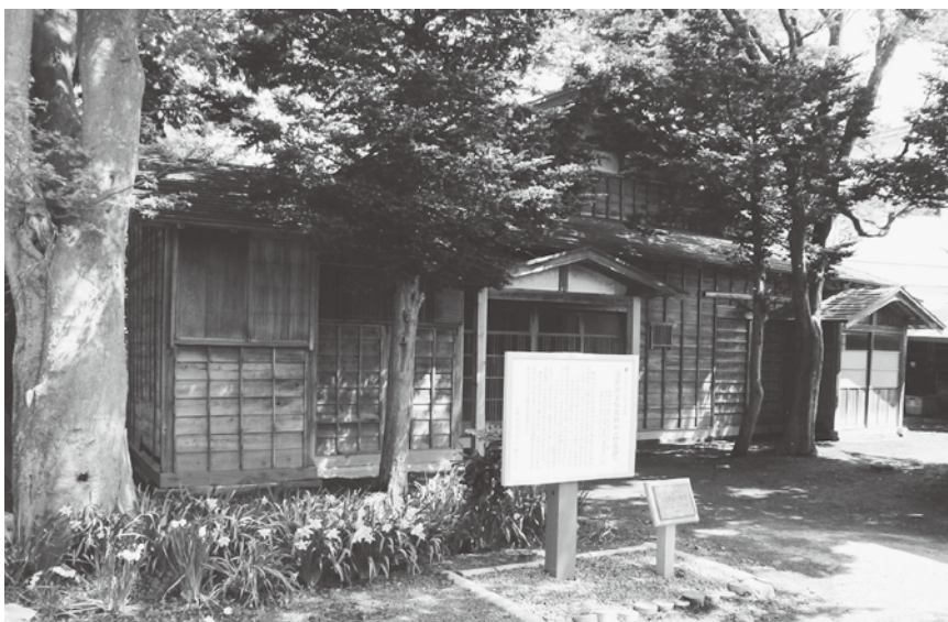
改修工事計画が進む行在所
