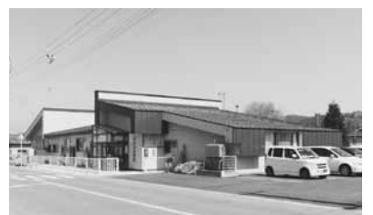
大規模改修工事を完了したわかば保育園
