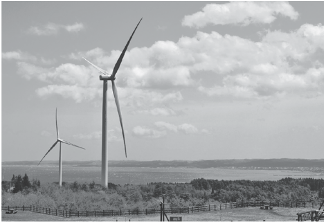
運転を開始した「野辺地柴崎風力発電所」
