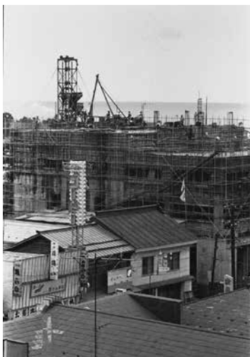
【写真①】工事中の野辺地電報電話局 撮影日：1966（昭和41）年 現在もある建物。工事はこのように行われました。
