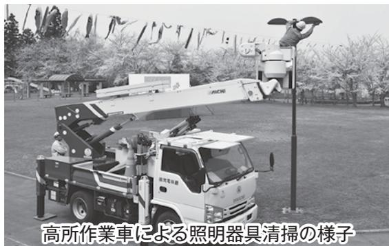
高所作業車による照明器具清掃の様子
